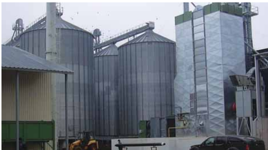
A BioDryer Szárítótelepi Rendszer Monostorpályiban. Balra: kazánház a napi tüzelőanyag adagolóval, kéménnyel. Középen a „kicsi” forróvíz-levegő hőcserélőt közrefogják a nagy silók és a szárítótorny.
