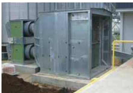
Forróvíz-levegő hőcserélő bekötés előtt
