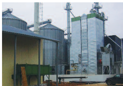
BioDryer növényi tüzelésű kazánal működő Szárítótelepi Rendszer Monostorpályiban
