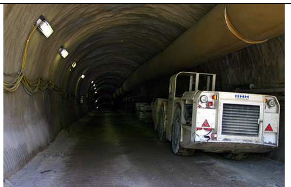
Bátaapáti, tároló bejárata
