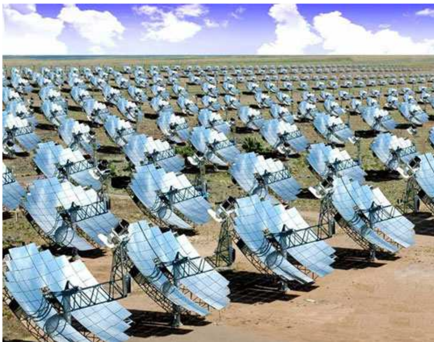
34. ábra. Több tükrös naptányéros naperómű (solar dish power plant) Stirling motorral
