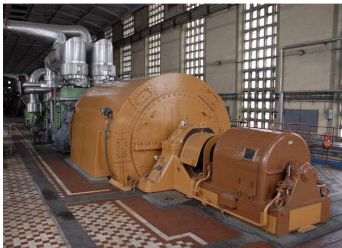
2. ábra Erőmű Pécsen. A gőzturбина és az 50 MW-os generátor
