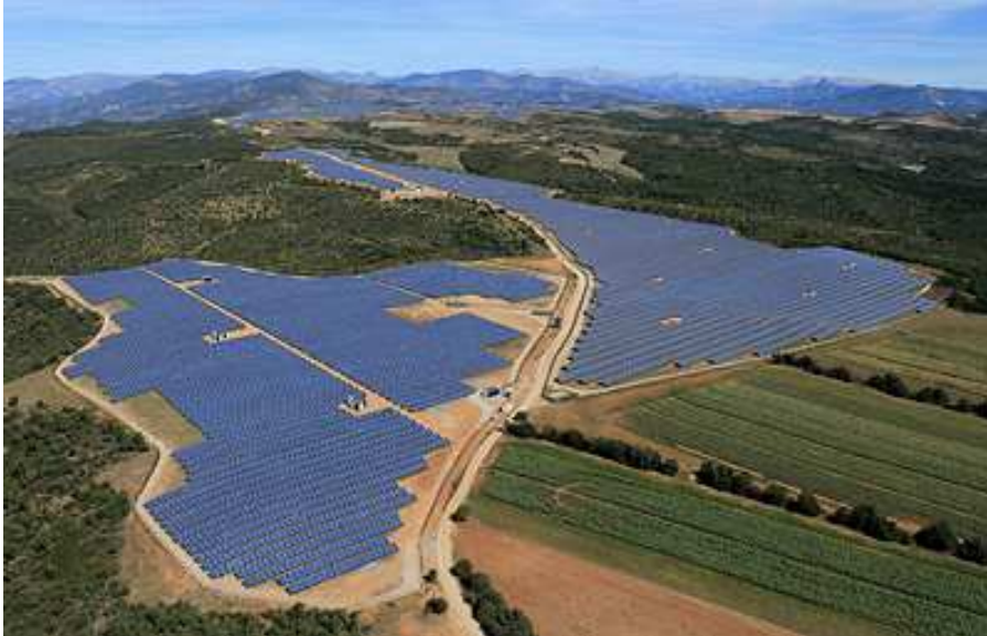
40. ábra. 2011-ben a Siemens Napelemekből álló „erőművet” telepített a La Colle des Mées fennsíkon a Francia Alpok közelében 112,000 napelem 70-hektáron. Csúcsteljesítmény 31 MW.
