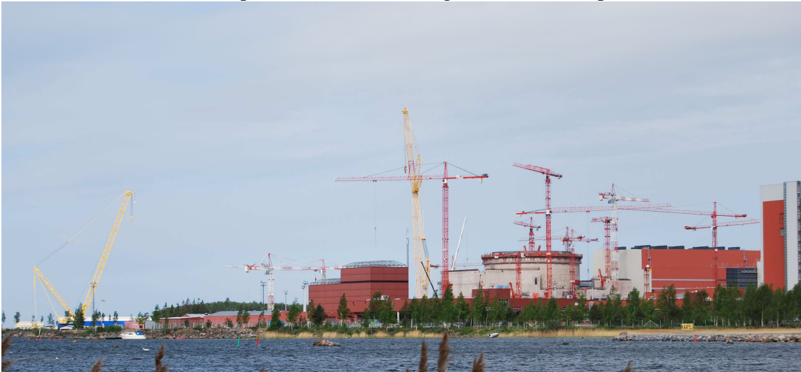
15. ábra: Az épülő új EPR blokk, Olkiluoto
