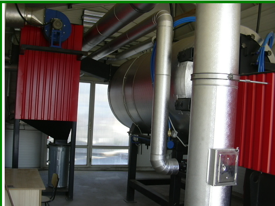
Uniferró Kft. 600 kW-os kazánház belül
