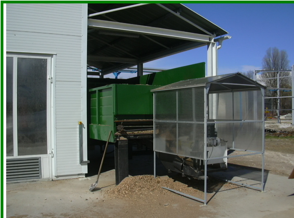
Uniferró Kft. 600 kW-os kazán épület 2008
