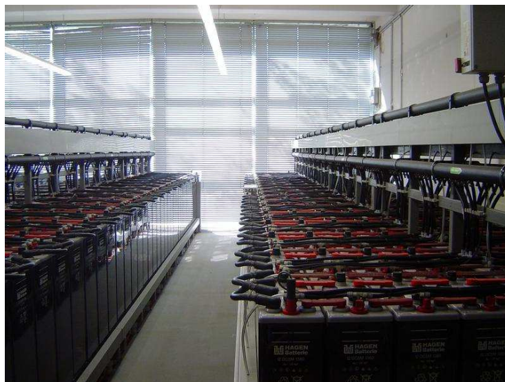
3.7. kép. Energiatárolás sorba kapcsolt akkumulátorokban ( http://idw-online.de )
