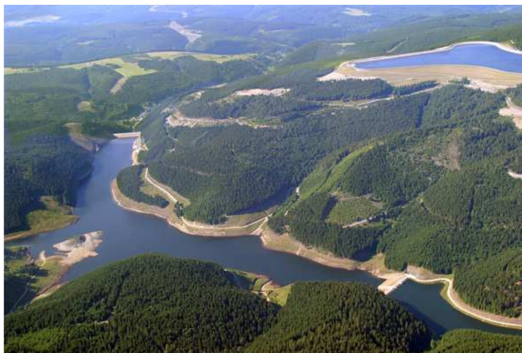
3.1. kép. Szivattyús-tározós-erőmű Goldistahl, Németország (www.hydroprojekt.de)
